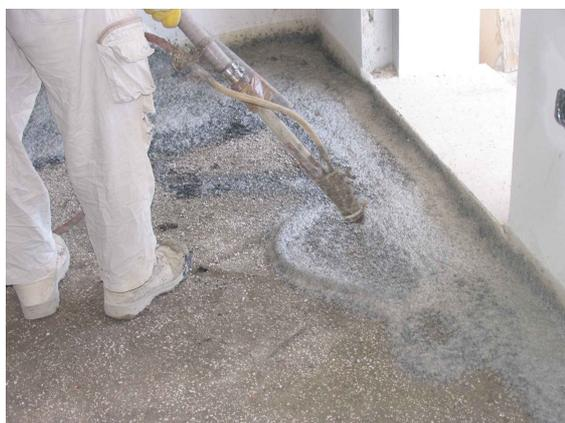
La tecnologia **Sprayrub®** è innovativa nei metodi applicativi e nei risultati raggiungibili poiché è basata sulla proiezione meccanica di miscele predosate a base di gomma SBR da realizzarsi sulle partizioni verticali e sulle partizioni orizzontali mediante l'impiego di attrezzature appositamente progettate.
